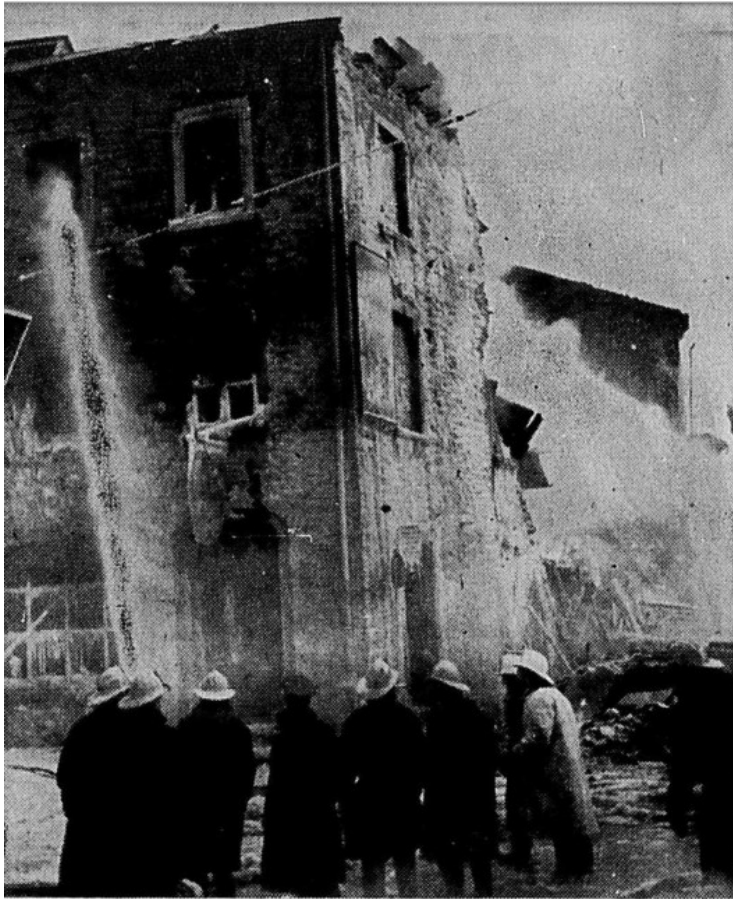
Mur éventré par la force de l'explosion
