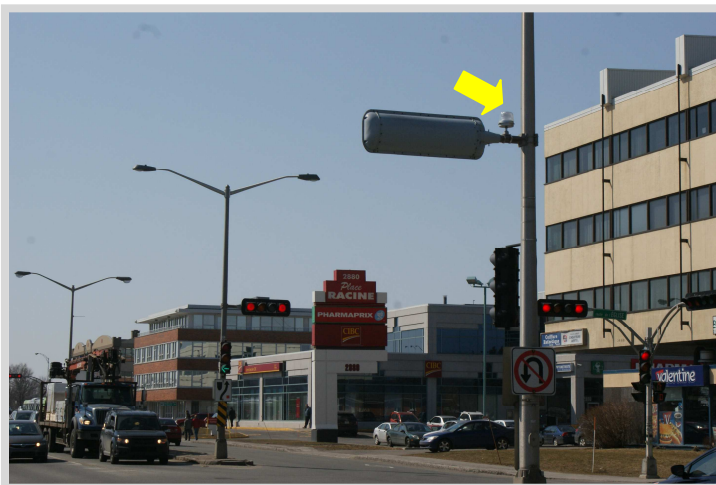
Feu de préemption installé à l'intersection de la route de l'Église et du Chemin des Quatre-Bourgeois
