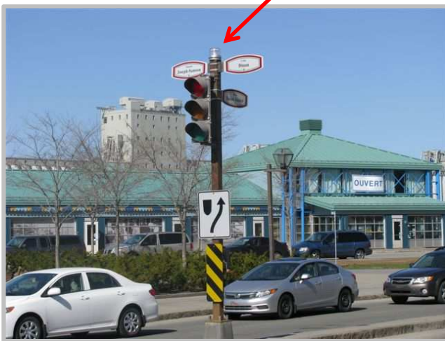
Feu de préemption installé à l'intersection du tunnel Joseph-Samson et de la Côte Dinan.
